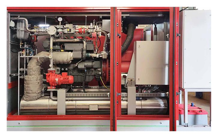
BK<sup>3</sup> baut BHKW-Module für die gängigen Brennstoffe und bietet auch Lösungen für Sonderanwendungen wie Erdölbegleitgas oder Deponiegas an. Ein BHKW besteht im Wesentlichen aus einem Motor (Mitte rechts), der in der Regel mit Gas betrieben wird und gleichzeitig Strom erzeugt sowie Wärme abgibt. Diese Abwärme wird über Wärmetauscher (links unten) zur Beheizung von Räumen oder Brauchwasser genutzt. Die Regelungseinheit (ganz rechts) steuert den Betrieb.
