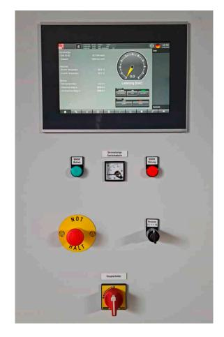
Die Regelungseinheit steuert den Betrieb der BHKW. BK<sup>3</sup> setzt dazu nach der Migration erstmals einen Touchpanel ein.
